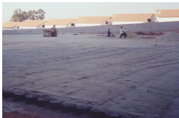
Compactação das geocélulas FORTCELL com o auxílio de um rolo vibratório liso.
