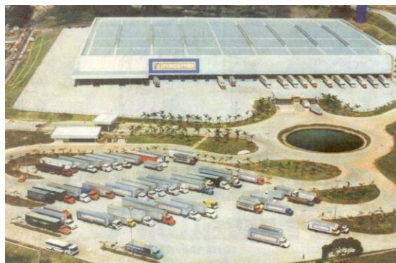
Vista aérea do pátio de um estacionamento após a instalação das geocélulas FORTCELL.
