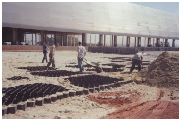
Disposição e preenchimento das geocélulas FORTCELL.
